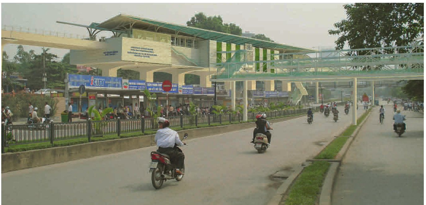
Vue architecturale d'une station de métro surélevée à Hanoi, Viêt Nam
