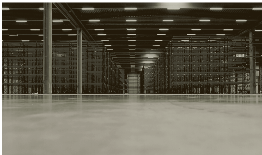
Construction d'installations logistiques, Roumanie
