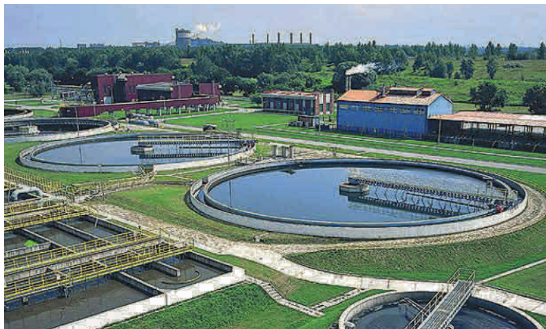
Straßenbahn Krakau, Polen Modernisierung des Abwassernetzes von Krakau, Polen
