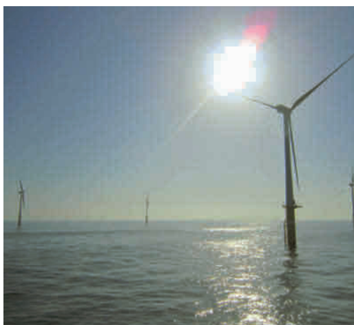
Offshore-Windpark vor Ostende, Belgien
