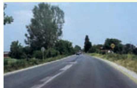
Instandsetzung von Straßen in Bosnien und Herzegowina
