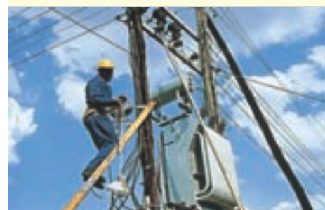
Modernisierung des Stromnetzes
