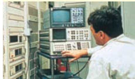
Modernisierung des Telekommunikationsnetzes
