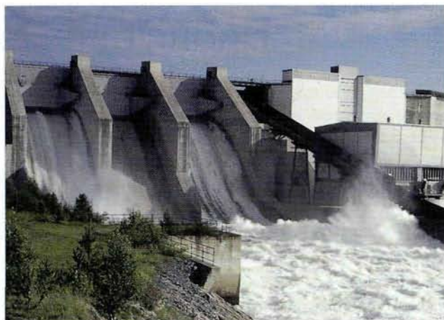
Central hidroeléctrica no norte da Suécia
