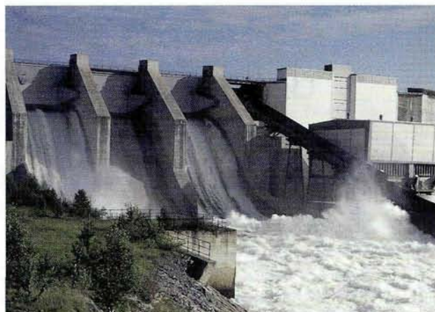
Una central hidroeléctrica en el Norte de Suecia
