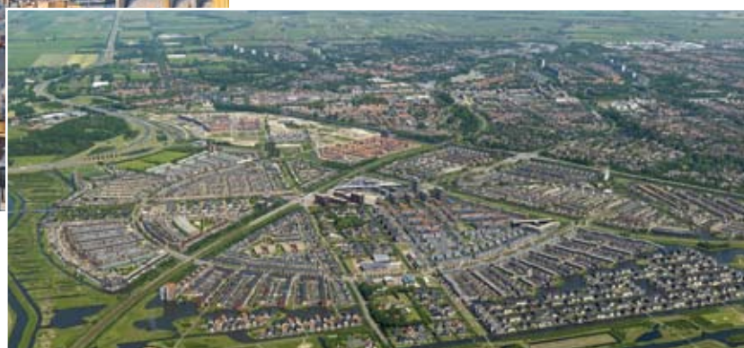
Amélioration de l'efficacité énergétique du réseau de chauffage urbain de Purmerend (Pays Bas)
