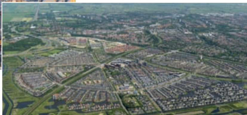
Verbesserung der Energieeffizienz des Fernwärmenetzes von Purmerend
