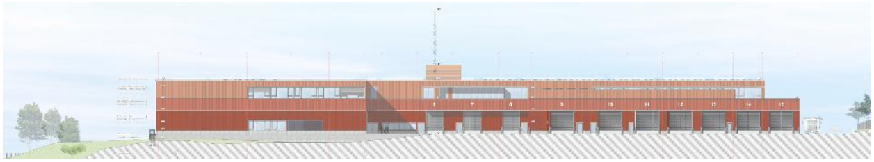
Figure 13 : Façade côté allée John W. Leonrad (Nord) ; Copyright Holweck Bingen Architectes
