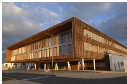
Avec des besoins énergétiques optimisés par une architecture et des matériaux adaptés, ce lycée professionnel consomme **13 fois moins de chauffage et 22 fois moins d'électricité qu'un lycée en conformité avec la réglementation en vigueur** au moment de sa conception. Isolation performante, toiture végétalisée, équipements à faible consommation d'énergie, micro-cogénération, panneaux photovoltaïques, gestion de l'eau...
