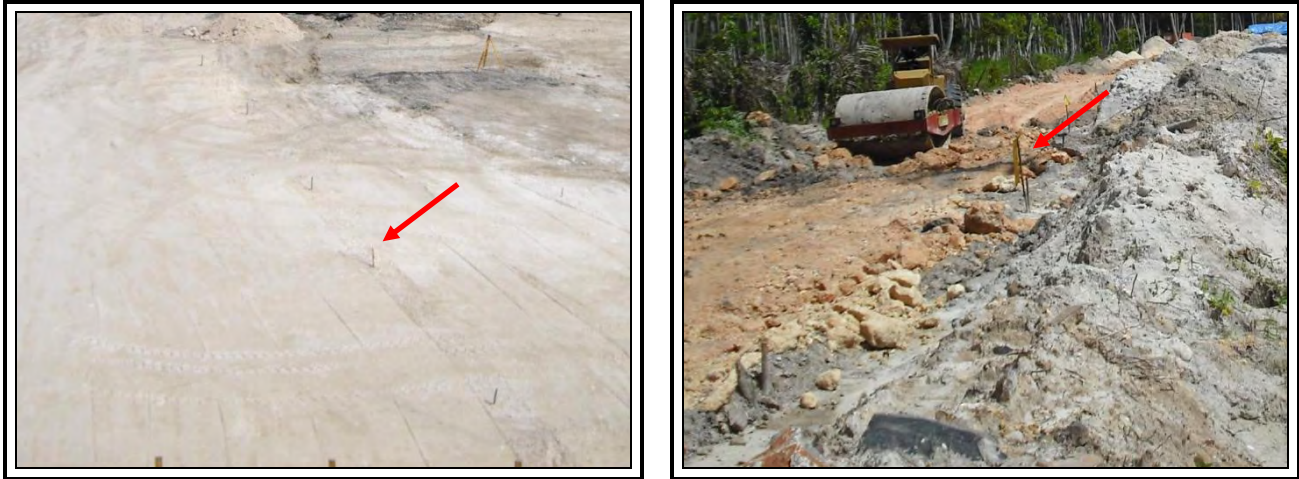
Fotos 7.2.2-1. A la izquierda se pueden ver estacas y a la derecha se observan estacas con cinta amarilla amarradas en el extremos de la misma.
