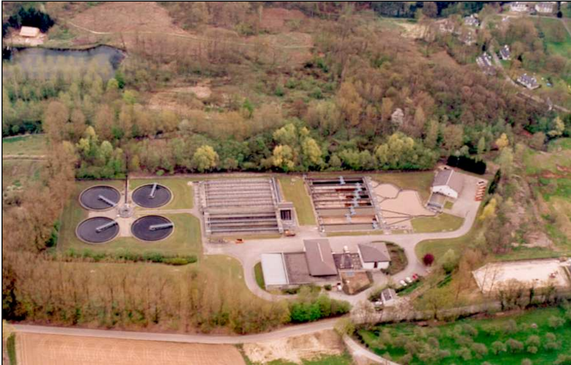
Photo 2: Vue générale de la station d'épuration depuis l'ouest
