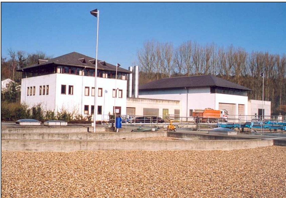
photo 3: vue générale du bâtiment principal
