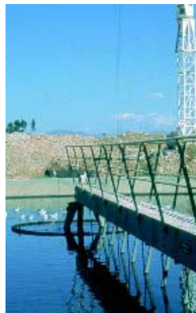
Station d'épuration, République d'Afrique du Sud
