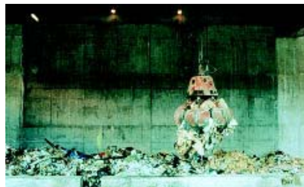
Traitement des déchets solides, Majorque, Espagne
