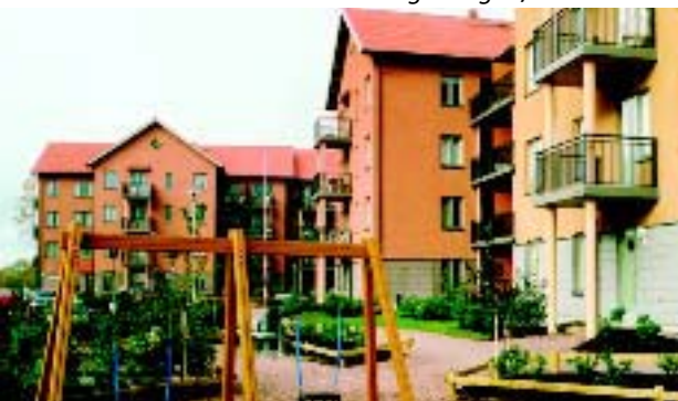
Infrastructures urbaines, Vantaa, Finlande
