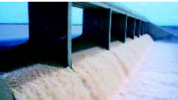
Wasserinfrastruktur, Ouagadougou, Burkina Faso
