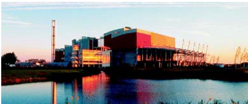
Müllverbrennungsanlage, Alkmaar, Niederlande
