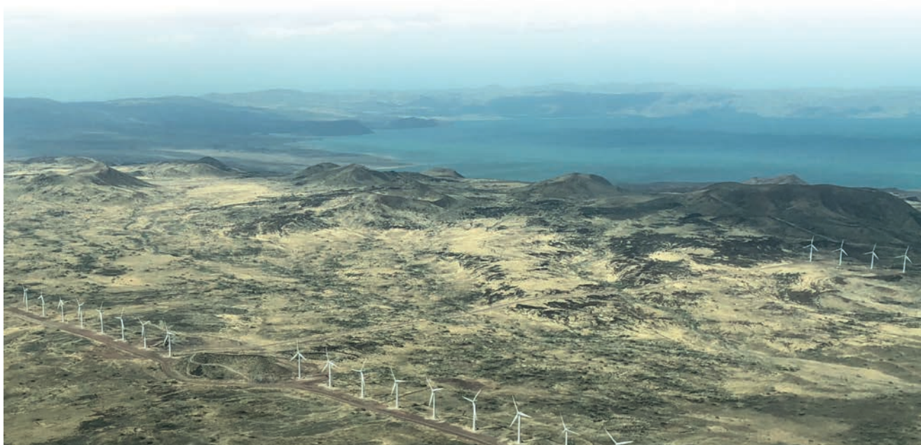
365 éoliennes ont été construites dans la région du lac Turkana, dans le nord du Kenya.
