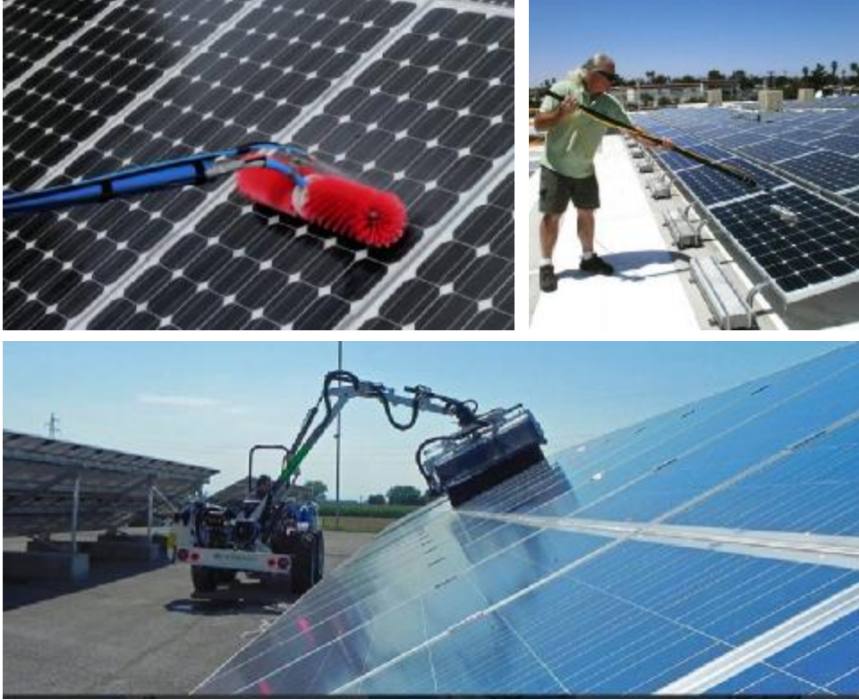
Şekil 26.Güneş paneli temizleme şekilleri
