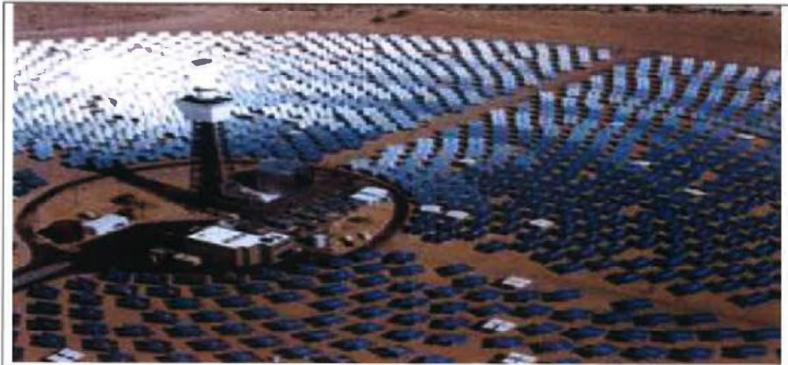
Fotoğraf VI.2.5.2.1. Güneş ışınlarını tek bir noktaya yönlendiren, aynalardan tesis edilen, Türkiye’de henüz bir örneği bulunmayan güneş enerjisi santrali
