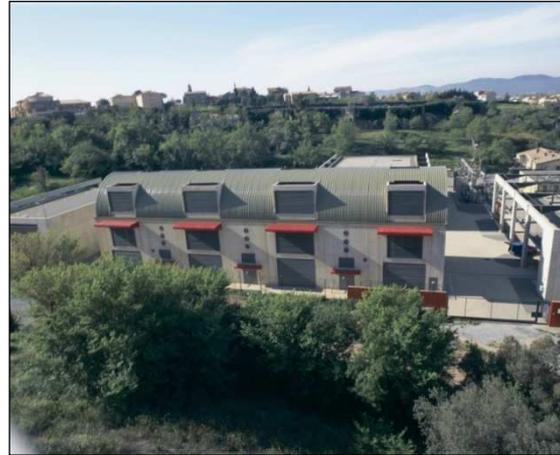
**Photographies 1, 2 et 3 : Exemples de PSEM 225 000 / 63 000 volts - (données RTE)**
