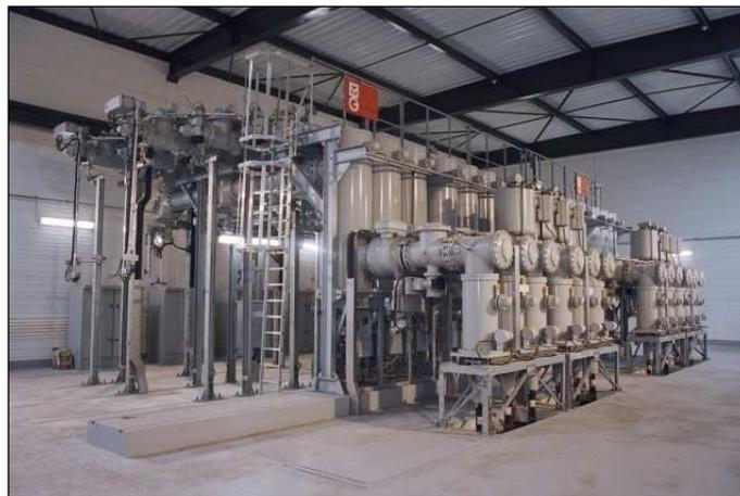
**Photographie 4 : Vue d'un poste sous enveloppe métallique - (données RTE)**
