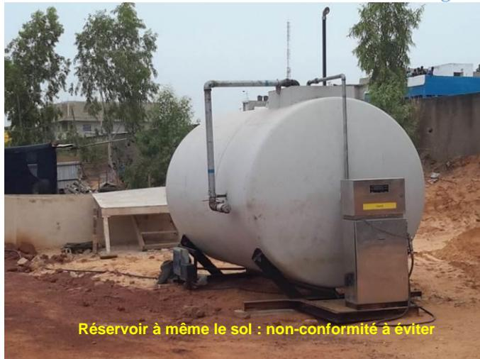
La cuve à gasoil devra être surélevée et une dalle étanche d'un volume égal au double de la capacité de la cuve devra être aménagée avec un système d'étanchéité qui n'autorisera aucune infiltration en cas de déversement. Des moyens de prévention devront être prédisposés dans la base comme les pictogrammes de sécurité, des extincteurs ABC d'au moins 50 kg, un bac à sable muni de pelle, des ancrages de cuve pour assurer la stabilité du réservoir, etc.
