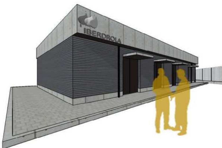
Figura 3.4 – Vista geral do edifício técnico do Posto de Corte do Alto Tâmega
