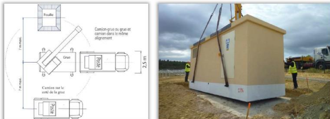
Photo 4 : Schéma de dépose des postes préfabriqués
