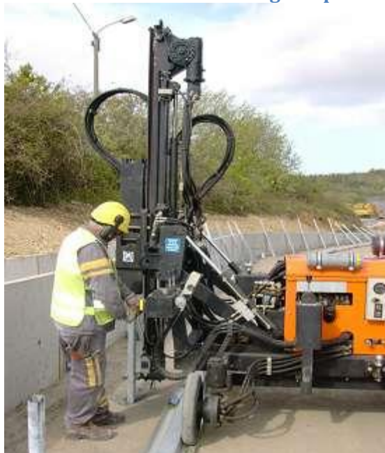
Photo 3 : Machine de battage de pieux
