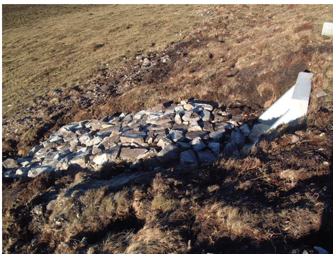
Figura 59 –Detalle embocadura de aleta en viales y escollera de piedra
