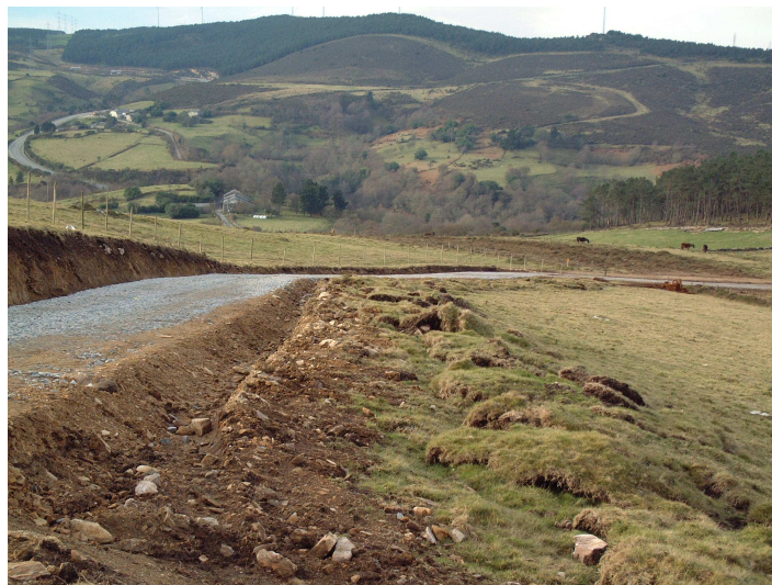
Figura 57 – Cordón de tepes depositado a un lado del ramal abierto
