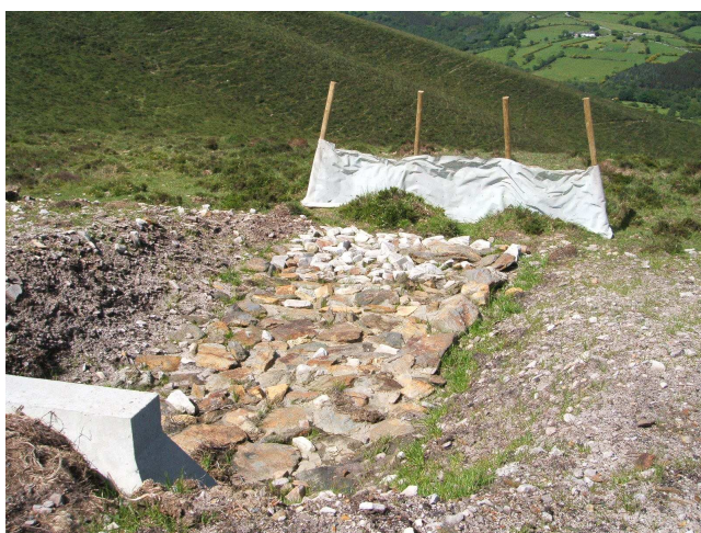
Figura 60 –Detalle de red de retención de sólidos a la salida de aguas
