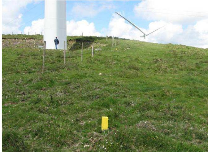
Figura 5 – Mojoneros señaladores en zanja de cableado restaurada
