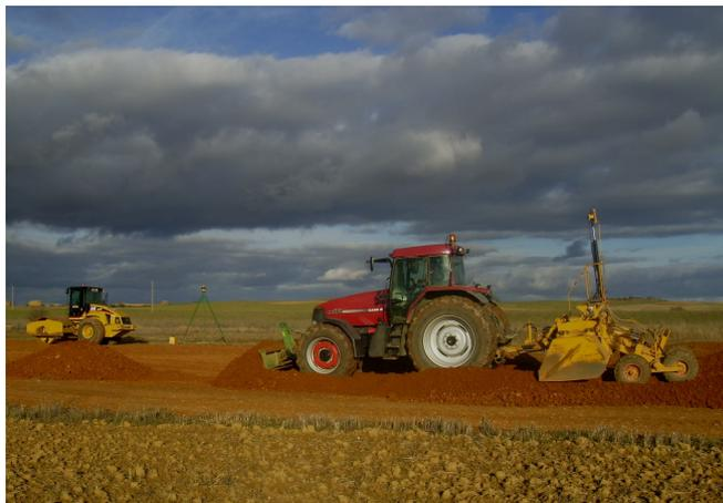
Figura 3 – Vista de traílla hidráulica extendiendo y nivelando tierra vegetal en un vial
