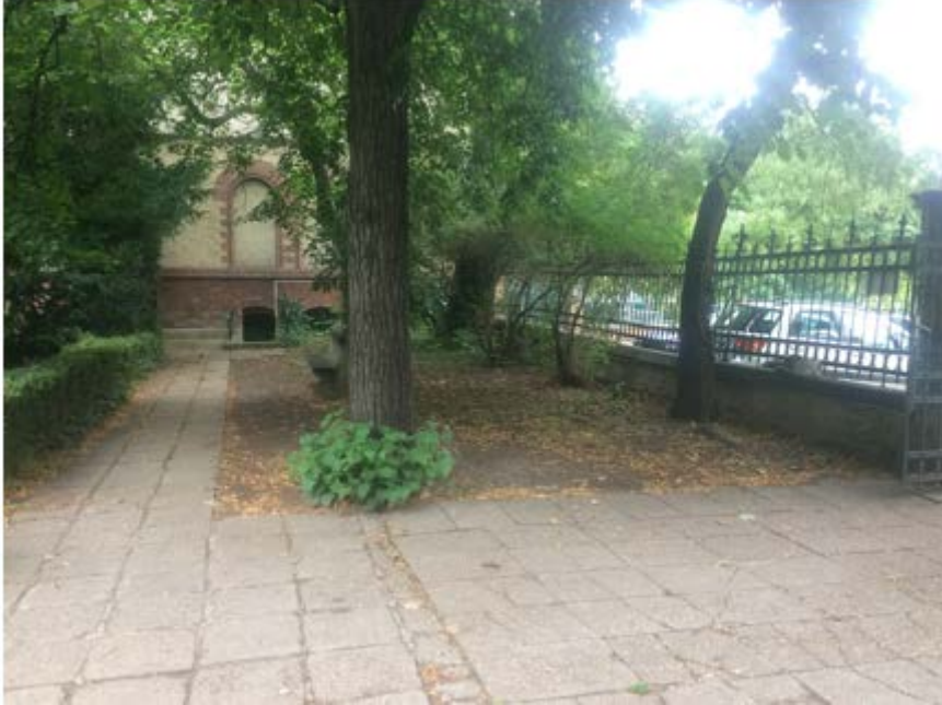
1. kép: Győri út felőli, felújítandó kerítés és kapu
