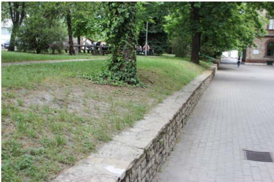
10. kép: Főépület nyugati oldalának támfala
