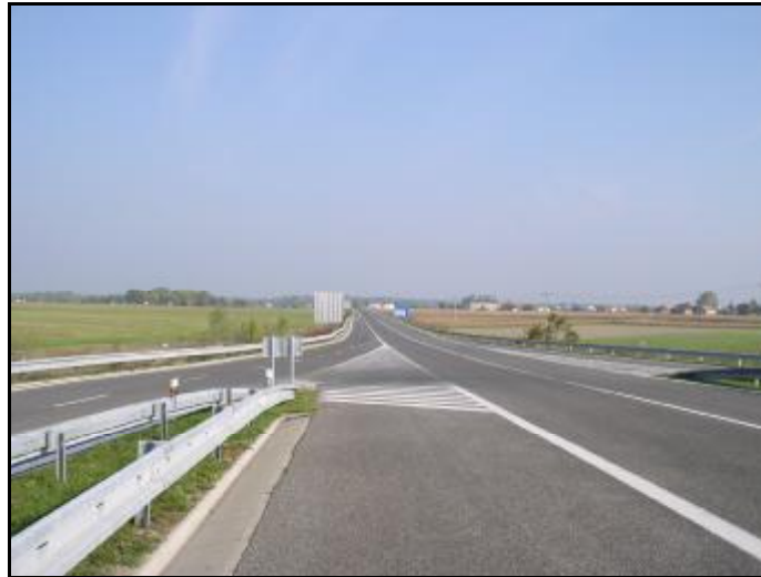
Pohľad na začiatkový úsek diaľnice D4 v smere staničenia
