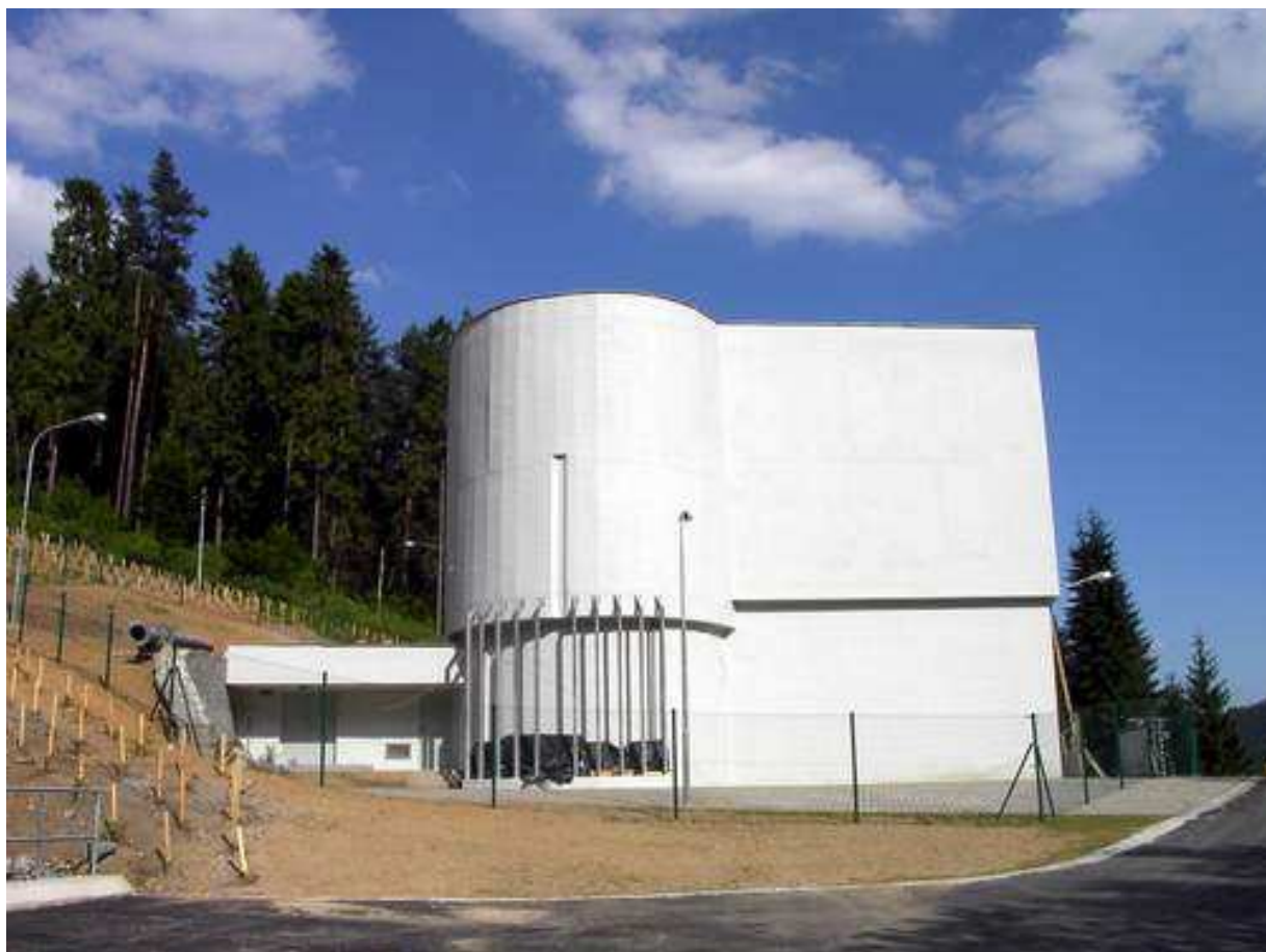
Obr.33: Výdych stredovej ventilačnej šachty tunela Branisko - ilustratívny príklad (pohľad zo zeme)
