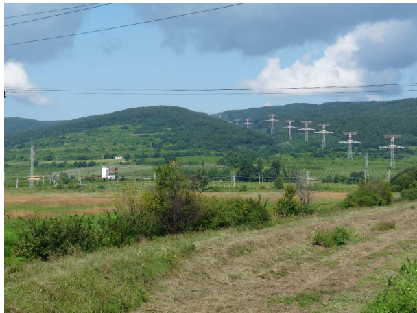
Obr.15: Pohľad na východný portál tunela Karpaty (7a,7b,7c)
