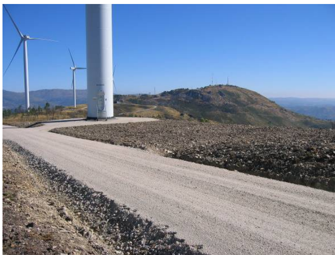
Figura 4.3 – Exemplo da plataforma de um aerogerador após recuperação
