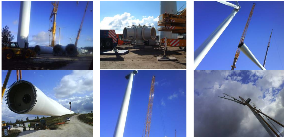
Figura 4.11 – Transporte e montagem das pás de um aerogerador
