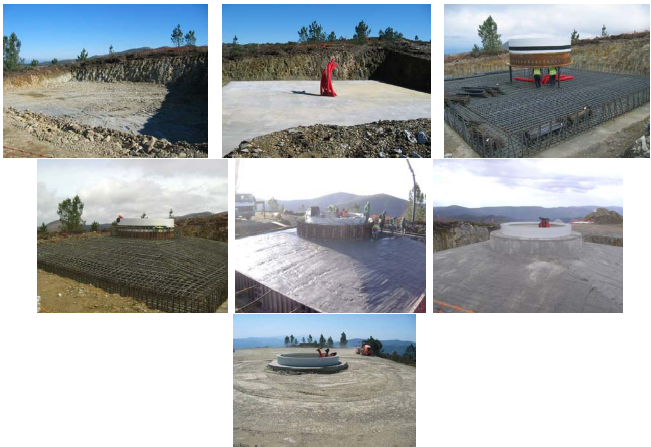
Figura 4.8 – Exemplo de execução da fundação da torre de um aerogerador
