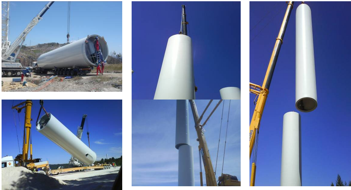
Figura 4.10 – Montagem da torre de um aerogerador
