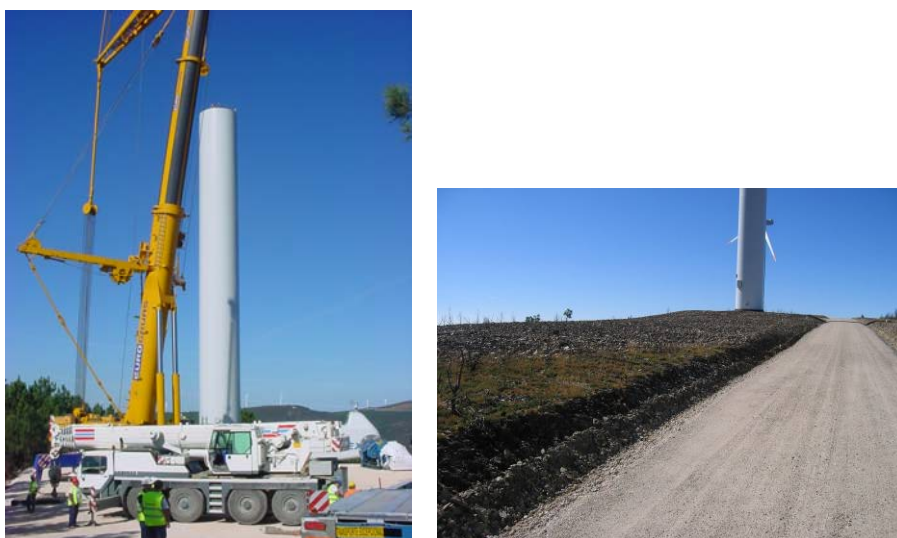
Figura 4.4 – Plataforma de trabalho adjacente a um aerogerador, à esquerda durante a fase de montagem e à direita após a recuperação paisagística.
