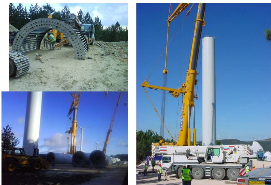
Figura 4.9 – Ocupação de uma plataforma para montagem de um aerogerador
