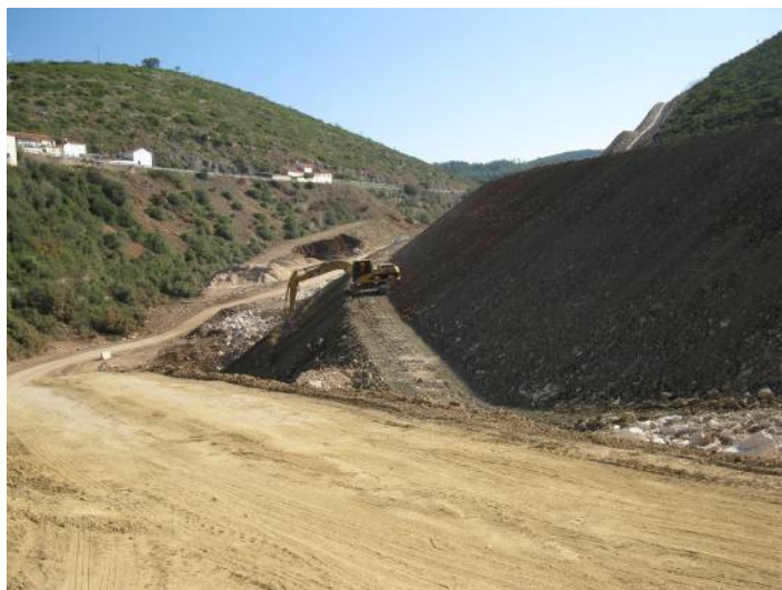
Fotografia 5.30 – Aspeto da construção do IC9, na área correspondente ao corredor de estudo da linha elétrica
