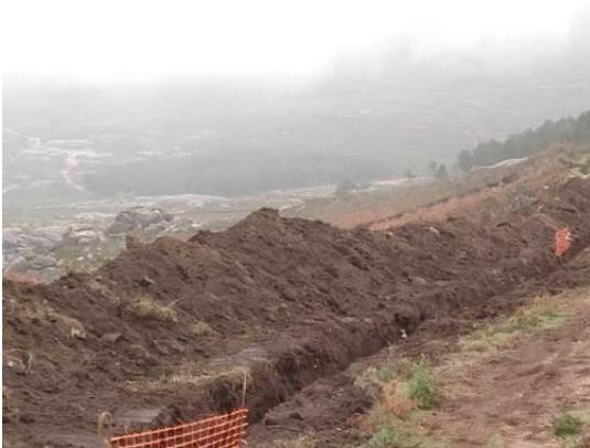
Exemplo de separação e armazenamento de terra vegetal ao longo de uma vala
