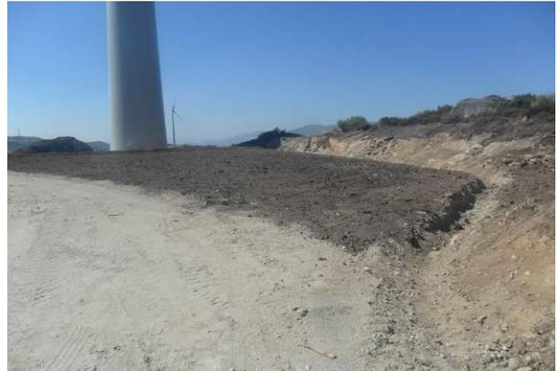
Recuperação ambiental com modelação de taludes e recuperação da plataforma de montagem de um aerogerador
