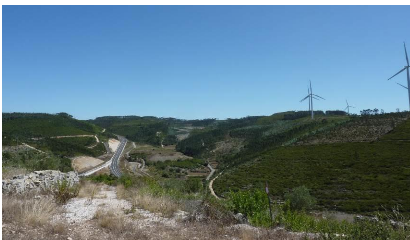
Fotografia 6.1 – Vista para a área de estudo da Linha Elétrica entre o IC9 e o Parque de Chão Falcão (Apoios 4 e 5)
