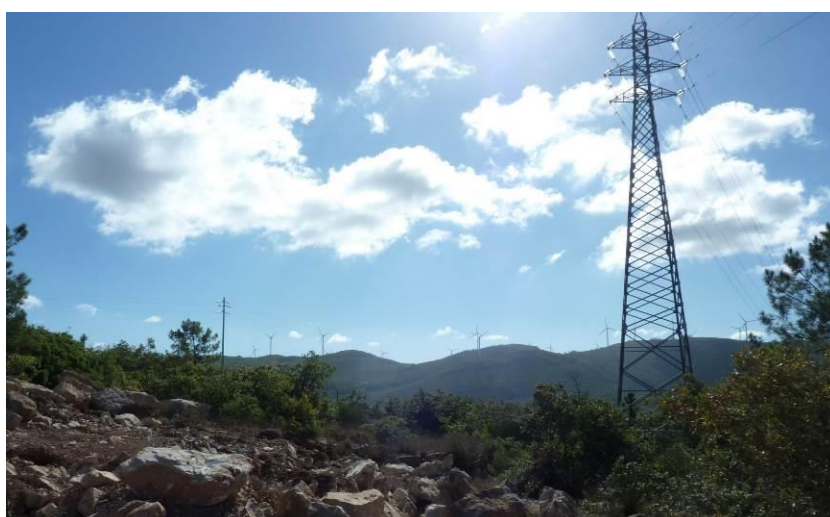
Fotografia 6.10 – Linhas Elétricas na envolvente próxima à Linha Elétrica e Parque Eólico de Chão Falcão (Apoios 20 e 21/15)
