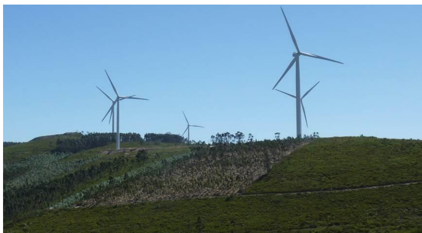
Fotografia 6.8 – Parque Eólico de Chão Falcão II (Apoios 6 e 7)
