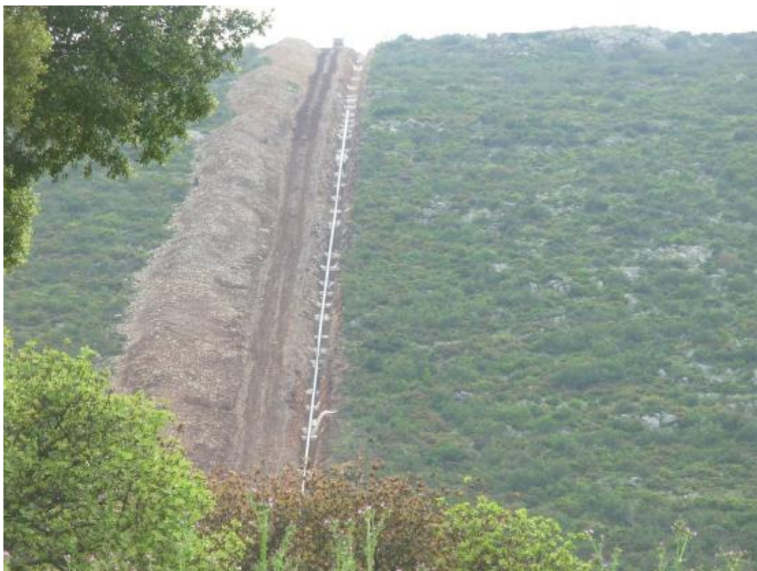
ΦΩΤ.22 Ο σωληναγωγός τοποθετημένος στο όρυγμα. PHOTO.22 Pipeline in Trench
