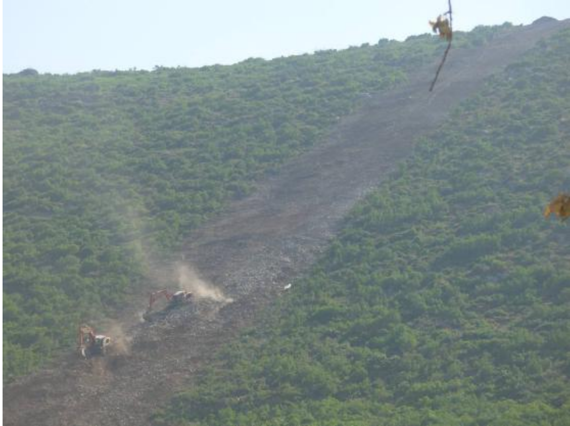
ΦΩΤ.20 Προετοιμασία Ζώνης Εργασίας. PHOTO.20 ROW Preparation
