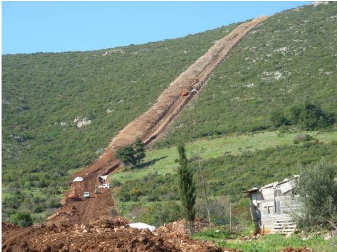
ΦΩΤ.21 Προετοιμασία Ζώνης Εργασίας. PHOTO.21 ROW Preparation
