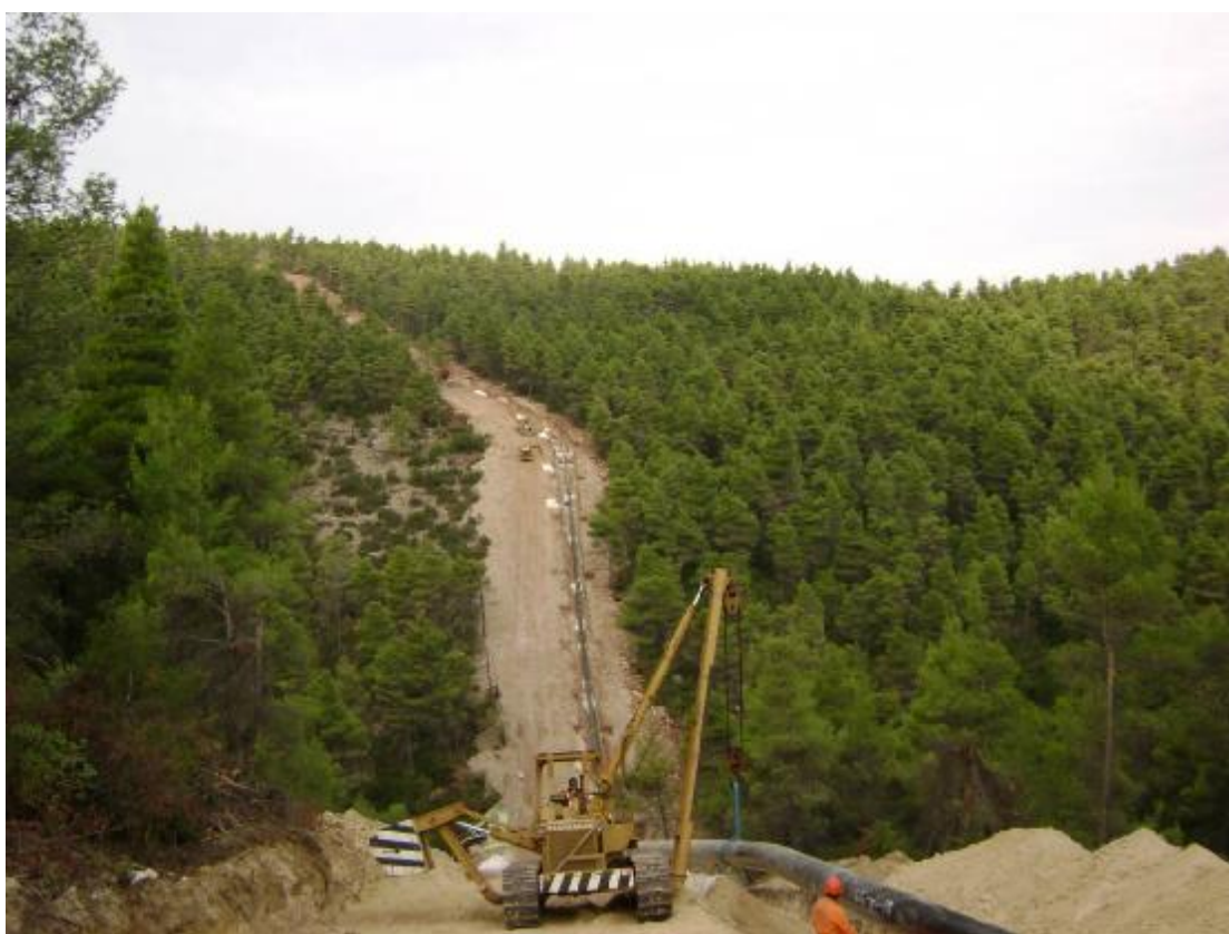
ΦΩΤ.23 Κατέβασμα σωληναγωγού στο όρυγμα. PHOTO.23 Pipeline Lowering in Trench
