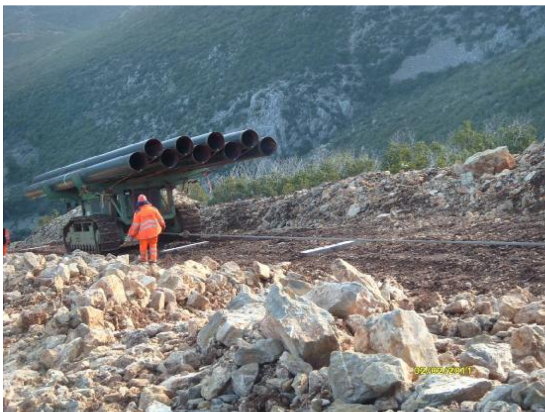
ΦΩΤ.25 Μεταφορά σωλήνων σε μεγάλη κλίση. PHOTO.25 Pipe transportation in large slope.
