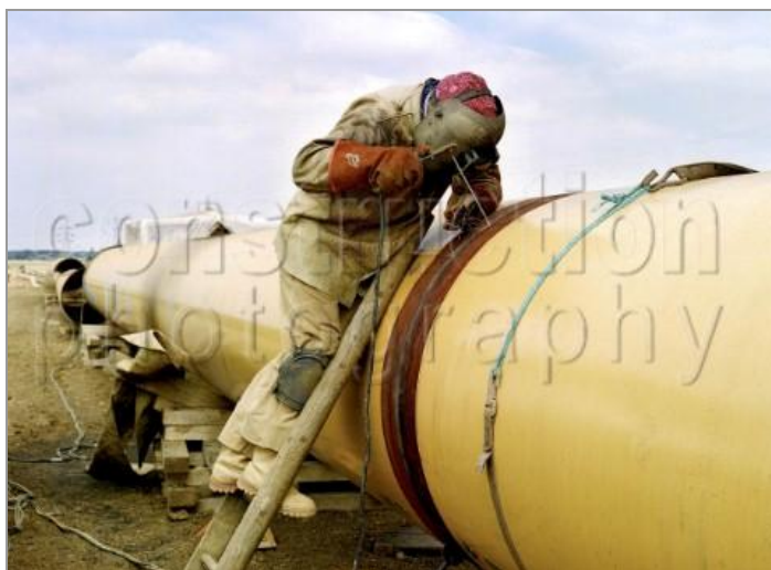
ΦΩΤ.32 & 33 Κάμψη και συγκόλληση αγωγού στο πεδίο. PHOTO.32 & 33 Pipeline field bending & welding.
