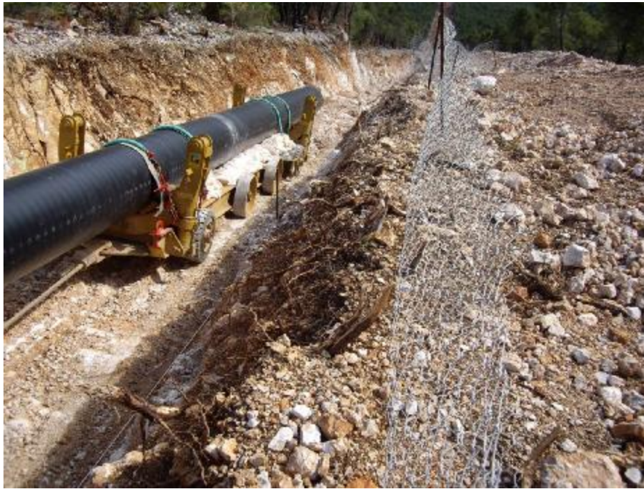
ΦΩΤ.31 Τράβηγμα του αγωγού με βαγονέτο. PHOTO.31 Pipeline dragging on cart.
