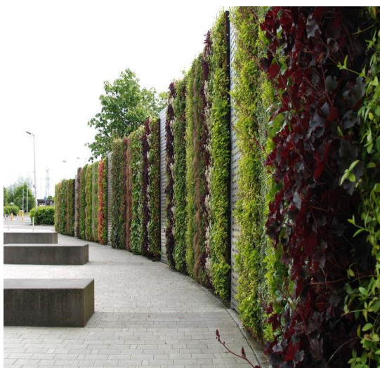
Fot. 10 Przykład zielonej ściany ( http://www.eauc.org.uk/image_uploads/leg_(17)_large.jpg )
