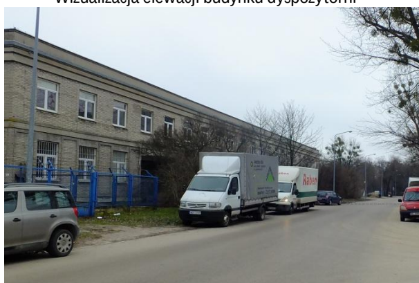
Fot. 14 Aktualny stan budynku administracyjno-biurowego
