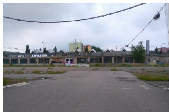
Fot. 17 Plac i budynki zajezdni
