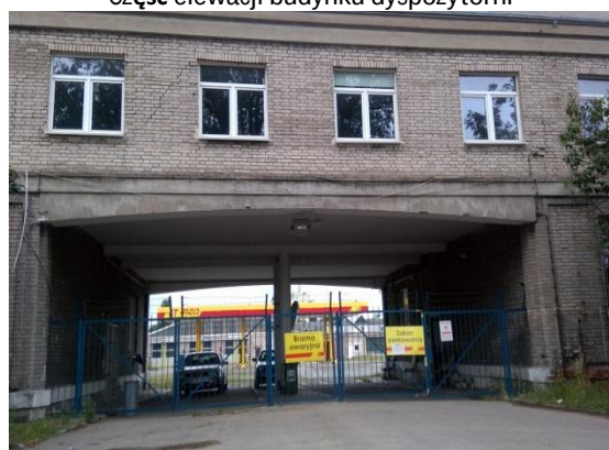
Fot. 15 Aktualny stan budynku administracyjno-biurowego
