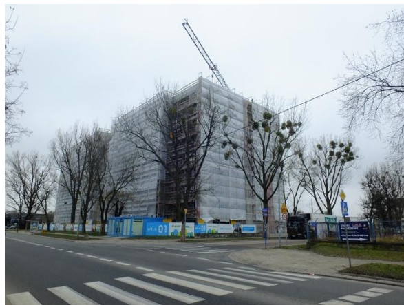
Fot. 5 Nowy budynek mieszkalny powstający przy ul. Nakielskiej
