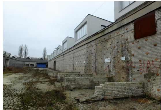
Fot. 13 Budynek zajezdni
