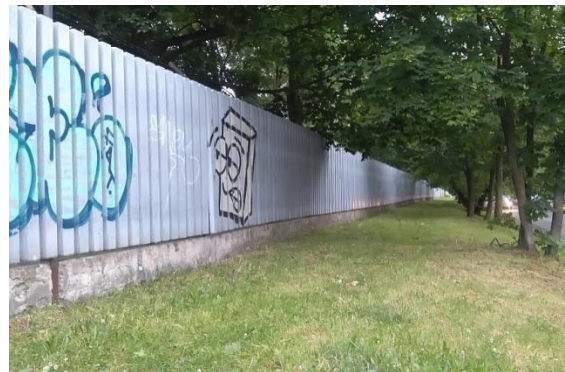
Fot. 11 Ogrodzenie przy ul. Pustola
