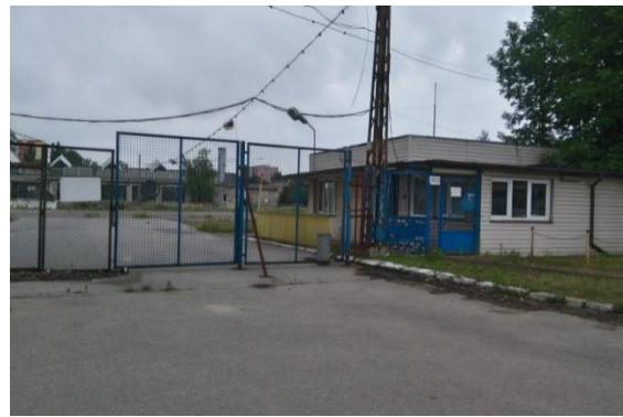
Fot. 15 Wjazd na teren zajezdni od ul. Nakielskiej
