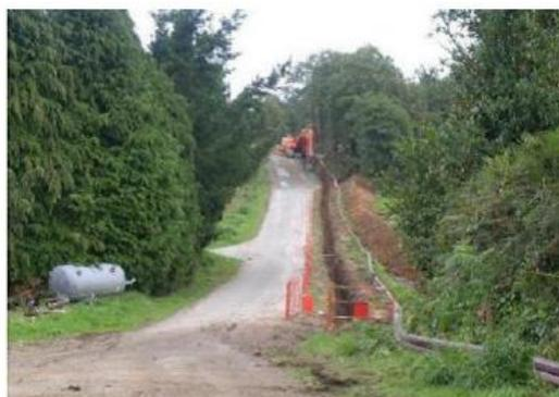
2. Les fourreaux PVC sont ensuite installés dans la tranchée, puis enrobés de béton.
