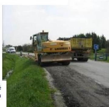
5. Le remblaiement de la tranchée est alors complété avec le sol d'origine (si passage en milieu naturel) ou la chaussée refaite (si passage sous voirie).
