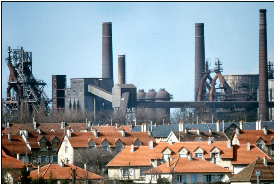
Figure 7 : Vue partielle des installations de la SMN en activité
