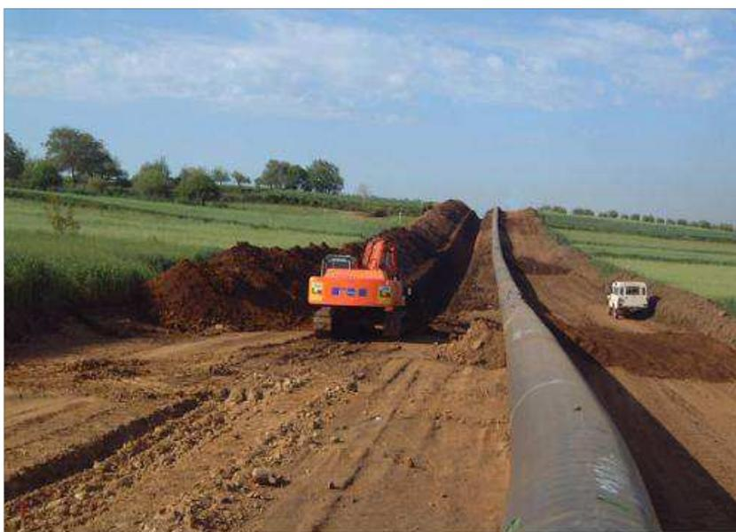
**Figura 5.d: Foto delle Tipiche Operazioni di Scavo della Trincea**
