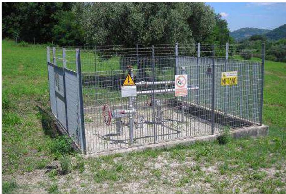
**Figura 5.h: Esempio di Punti di Intercettazione di Linea (PIL)**
