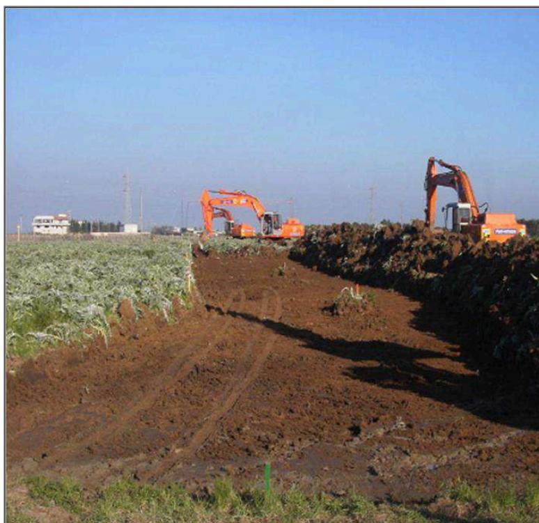
**Figura 5.b: Foto delle Tipiche Operazioni di Apertura dell'Area di Passaggio**
