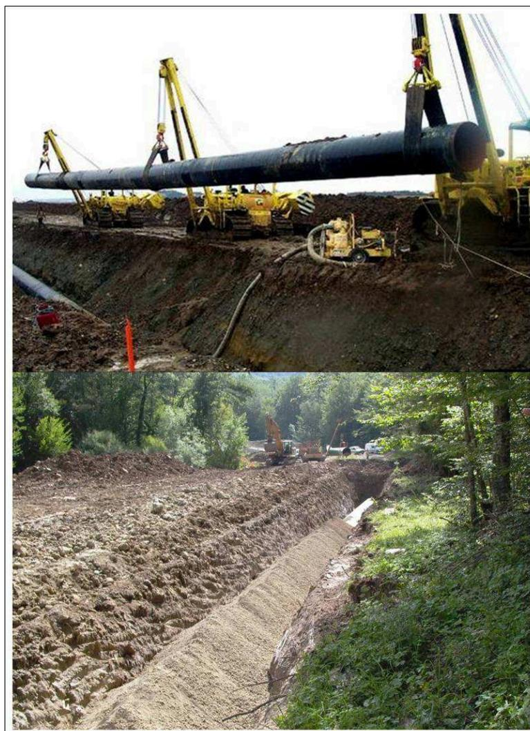
**Figura 5.e: Foto delle Tipiche Operazioni di Posa della Condotta**
