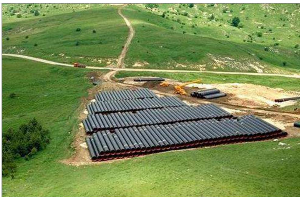
**Figura 5.a:Foto di una Piazzola per Accatastamento Tubazioni (Esempio)**
