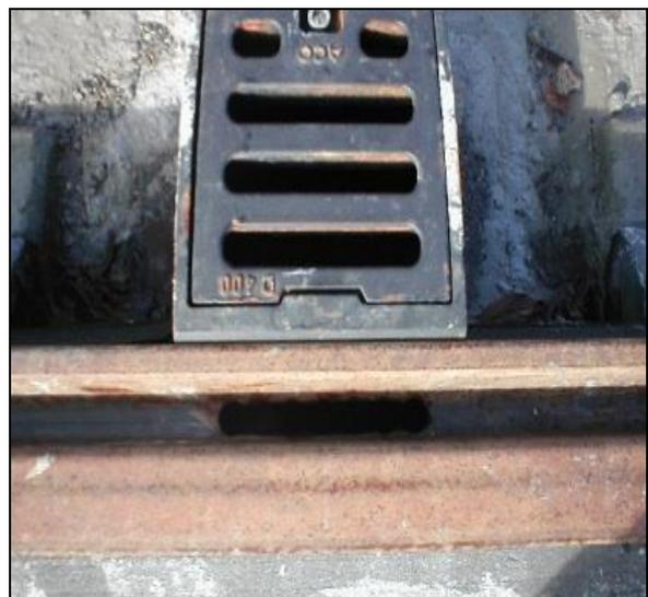
Tableau 5 : Caniveau de drainage et boîte de drainage avec grille verrouillée
