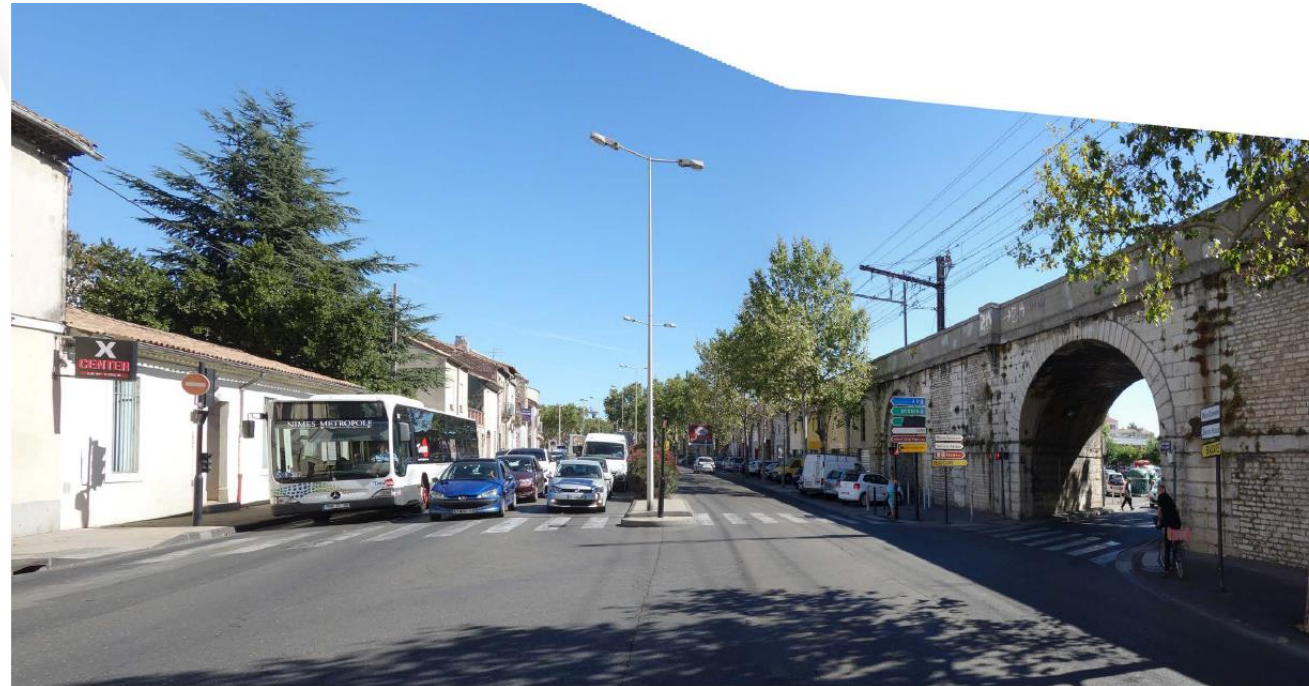
Figure 7 : Photographie Boulevard Talabot
