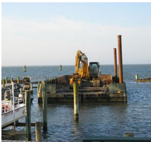
Figure 62 : Exemple de pelle mécanique sur barge autoélevatrice
