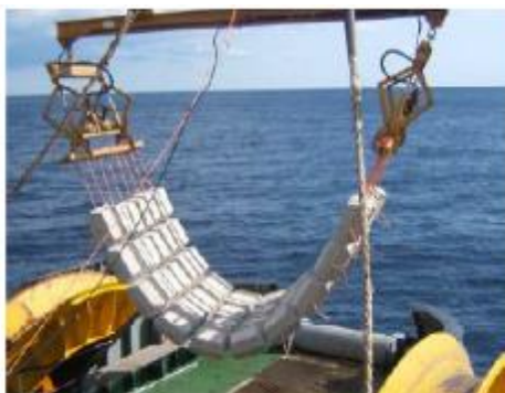
Figure 53 : Exemple de protection externe par matelas
