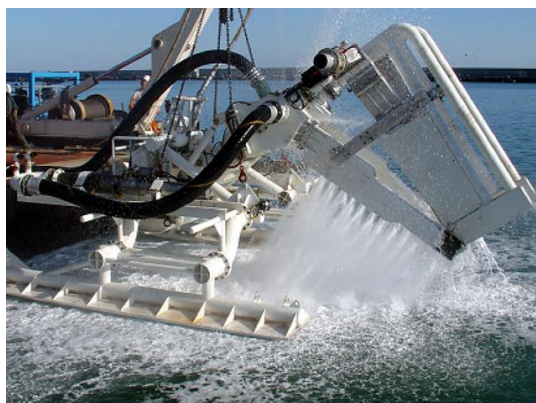
Figure 60 : Exemple de water jetting
