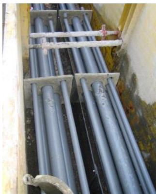
Figure 69 : Illustration d'une liaison souterraine à deux circuits
