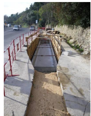
Figure 70 : Exemple d'une chambre de jonction pour un circuit à 225 000 volts
