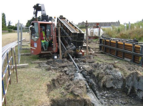
Figure 72 : Exemple d'un forage dirigé 4 trous ou 1 trou (suivant répartition des fourreaux)
