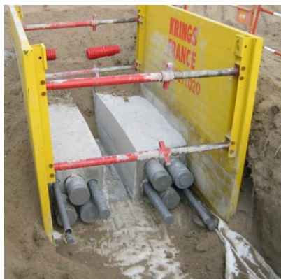
Figure 69 : Illustration d'une liaison souterraine à deux circuits
