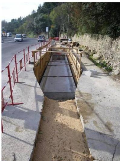
**Figure 26 : exemple d'une chambre de jonction pour un circuit à 225 000 volts**
