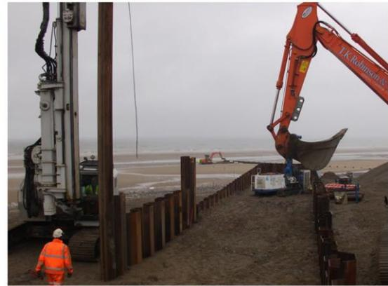
Figure 17 : exemple de tranchée ouverte sur la plage
