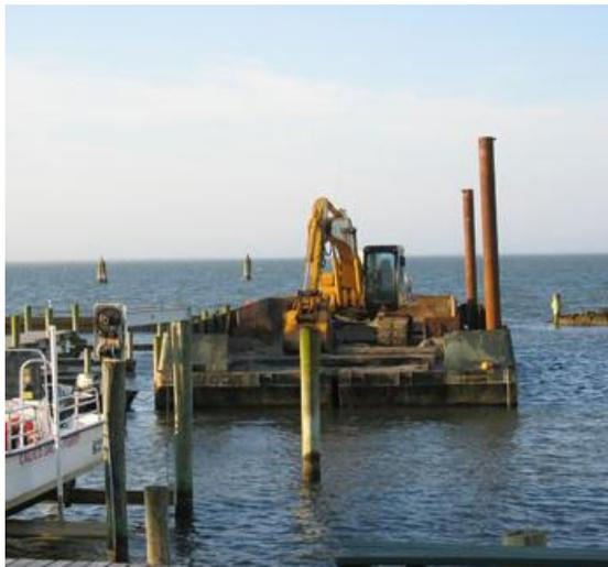
Figure 15 : exemple de pelle mécanique sur barge autoélevatrice
