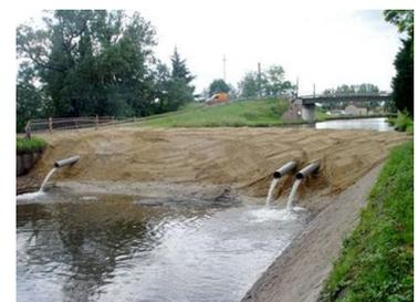
Figure 30 : exemples de batardeaux provisoires
