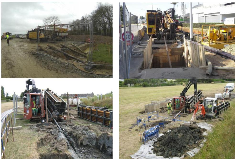
**Figure 28 : exemple d'un forage dirigé 4 trous ou 1 trou (suivant répartition des fourreaux)**
