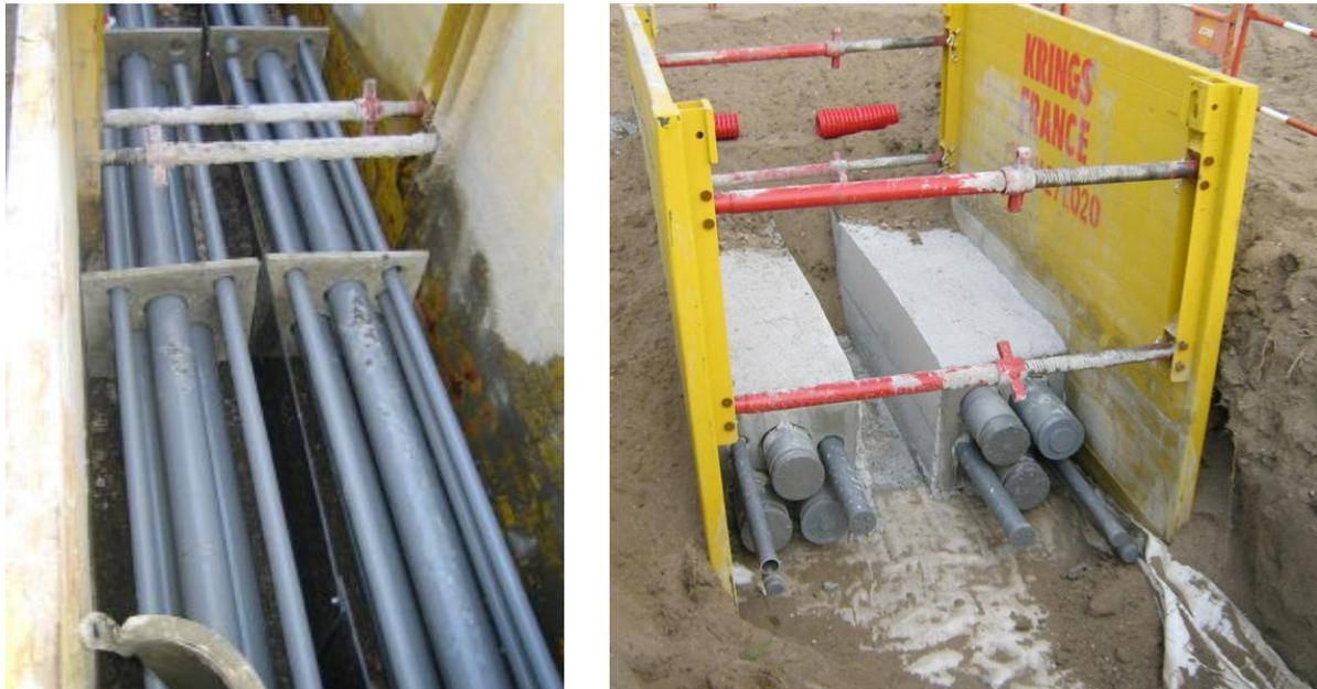
**Figure 25 : illustration d'une liaison souterraine à deux circuits**
