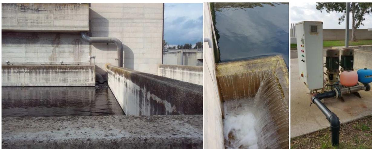
Figura 11 – A sx: vasca accumulo acque servizi. Al centro: scarico dell'effluente. A dx: pompe di sollevamento acqua servizi.
