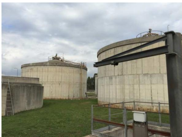
Figura 13 – Digestori anaerobici..
