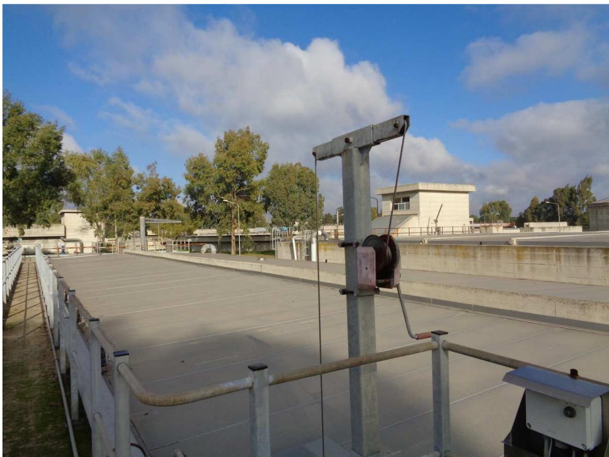
Figura 5 – In primo piano: vasca Equalizzazione Sud. Sullo sfondo: Equalizzazione Nord (è visibile il locale di alloggiamento dei motori delle coclee di sollevamento primario).
