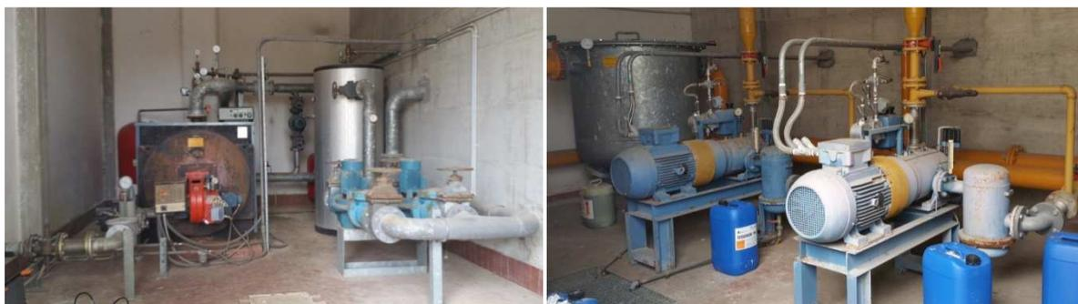
Figura 17 – A sx.: centrale termica. A dx.: compressori.
