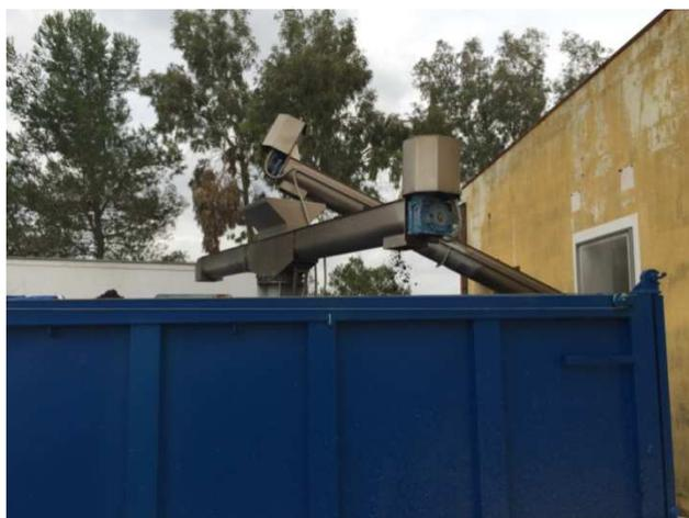
Figura 14 – A sx.: estrattori centrifughi. A dx.:coclea oscillante scarico fango disidratato.
