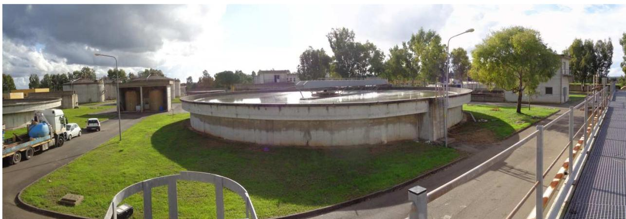
Figura 6 – Sopra, vista della stazione di flocculazione. Ai lati della fotografia sono visibili i due flocculatori a pianta ottagonale, al centro il pozzetto ripartitore e la stazione di stoccaggio e dosaggio del cloruro ferrico. Sotto, sedimentatore primario (sullo sfondo stazione di stoccaggio cloruro ferrico).
