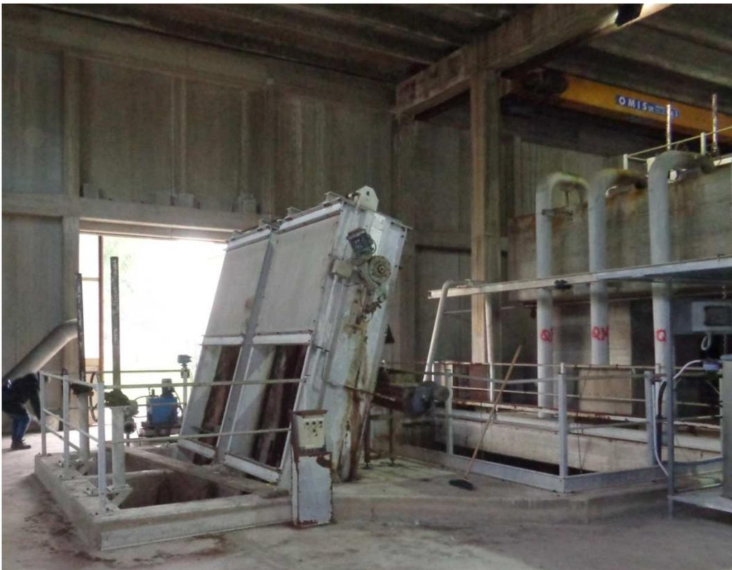
*Figura 3 – Canale di arrivo e sollevamento iniziale dei liquami. A sx sono evidenti le griglie grossolane, a dx tre delle quattro tubazioni di mandata delle pompe sommerse di sollevamento iniziale.*
