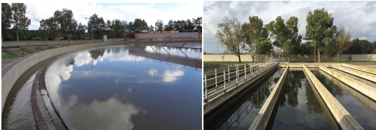
Figura 9 – A sx: sedimentatore secondario. A dx: vasche di contatto della disinfezione.
