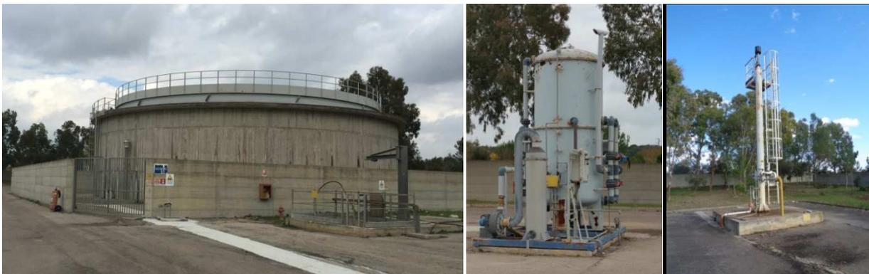
Figura 16 – A sx.: gasometro. Al centro: desolfatore. A dx.: torcia biogas.
