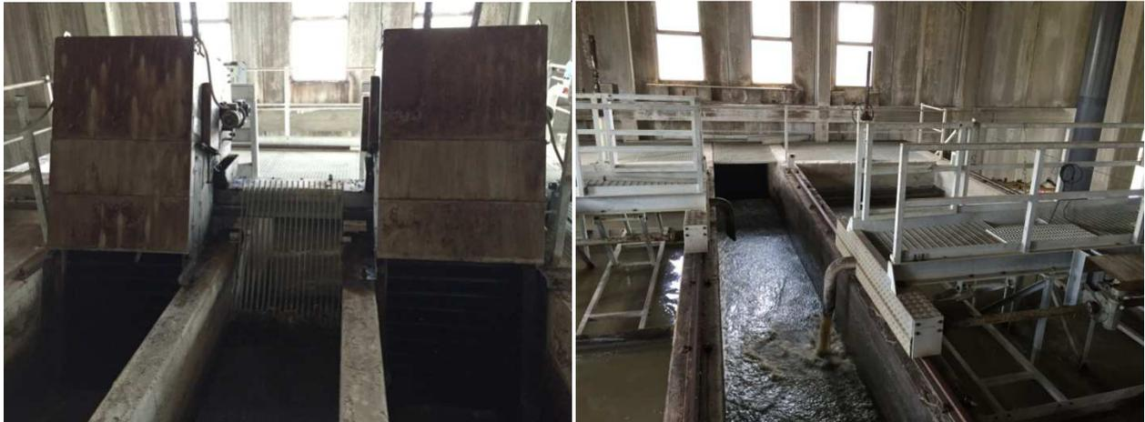
Figura 4 – A sx: Grigliatura fine (al centro la griglia manuale di bypass). A dx: dissabbiatori.
