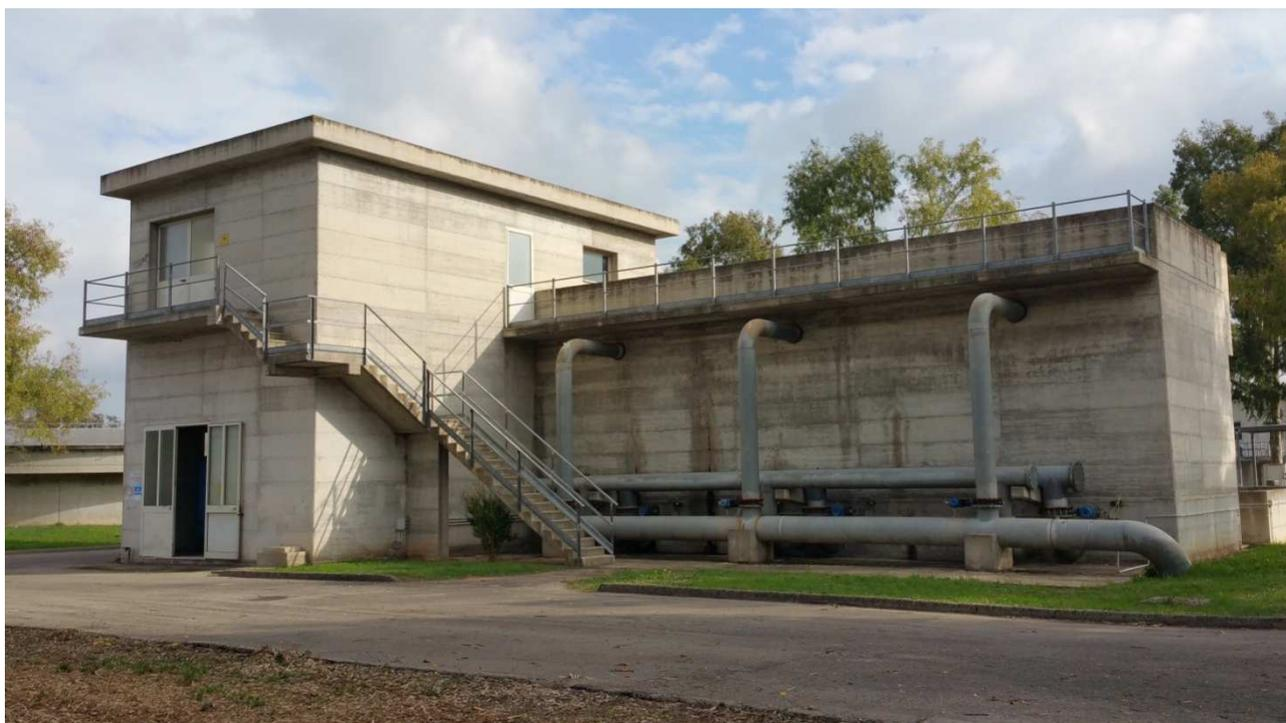
Figura 10 – Fabbricato della filtrazione (a dx. i filtri, a sx. locale quadri e soffianti).
