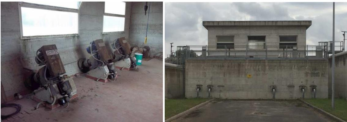
*Figura 8 – A sx. coclee ricircolo fanghi. A dx. retro della stazione di sollevamento fanghi di supero (sono evidenti le n.5 mandate).*
