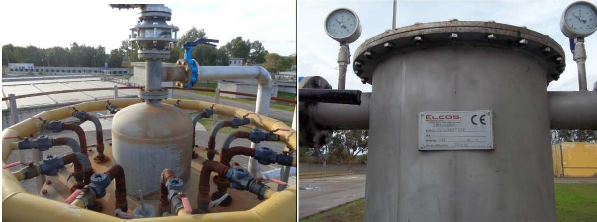
Figura 15 – A sx.: particolare cupola digestori. A dx.: filtro a ghiaia installato immediatamente a valle dei digestori.
