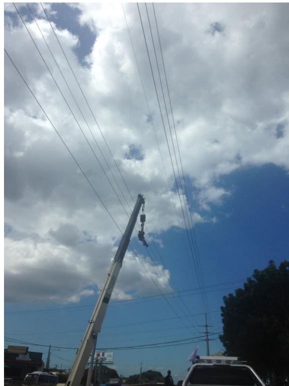
Figura 7.3 Mantenimiento de líneas de transmisión
