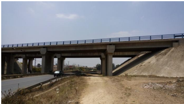
Photo 3 : Autoroute sur Pont de Iisafa
