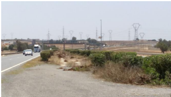
Photo 1 : Zone d'élargissement au niveau de la bifurcation Mohammedia
