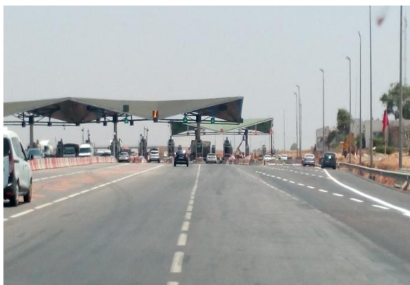
Photo 1 : Barrière pleine voie de Tit Mellil
