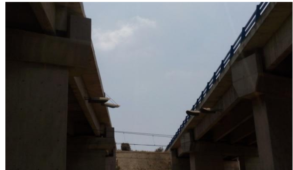
Photo 4 : Elargissement 2x3 à l'intérieur du pont
