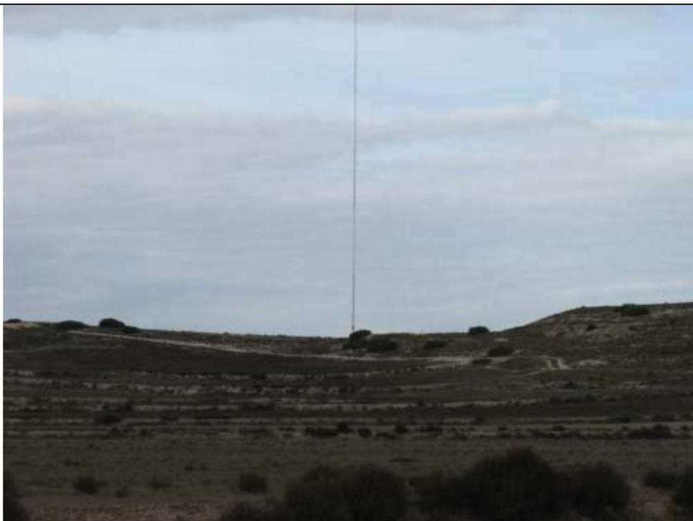
Foto 3: torre anemométrica instalada en la zona de actuación con el fin de obtener datos sobre el viento (velocidad, dirección predominante, etc.)
