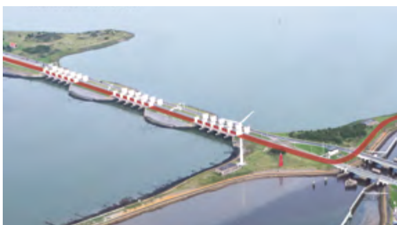
Afbeelding 8.1 Spuicomplex Den Oever in de huidige situatie
