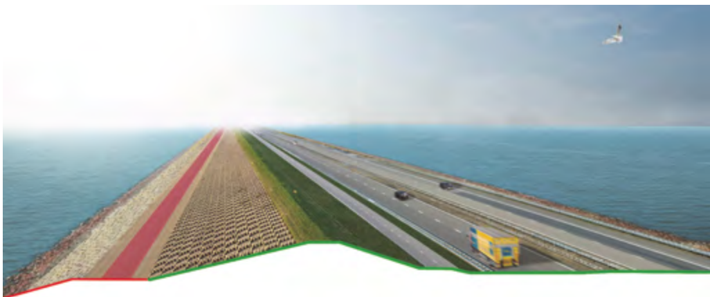
Afbeelding 5.7 Variant D1: aanpassen buitentalud met berm (collage)
