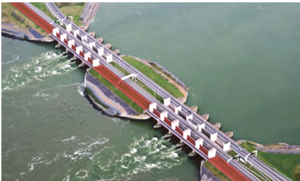
Afbeelding 9.1 Spuicomplex Kornwerderzand in de huidige situatie
