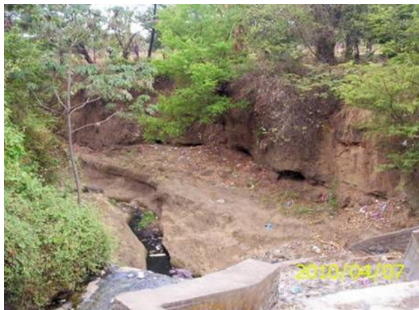
Río Curiance (Puente Rolando Rodríguez)
