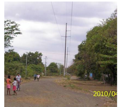
Líneas en derecho de vía férrea
