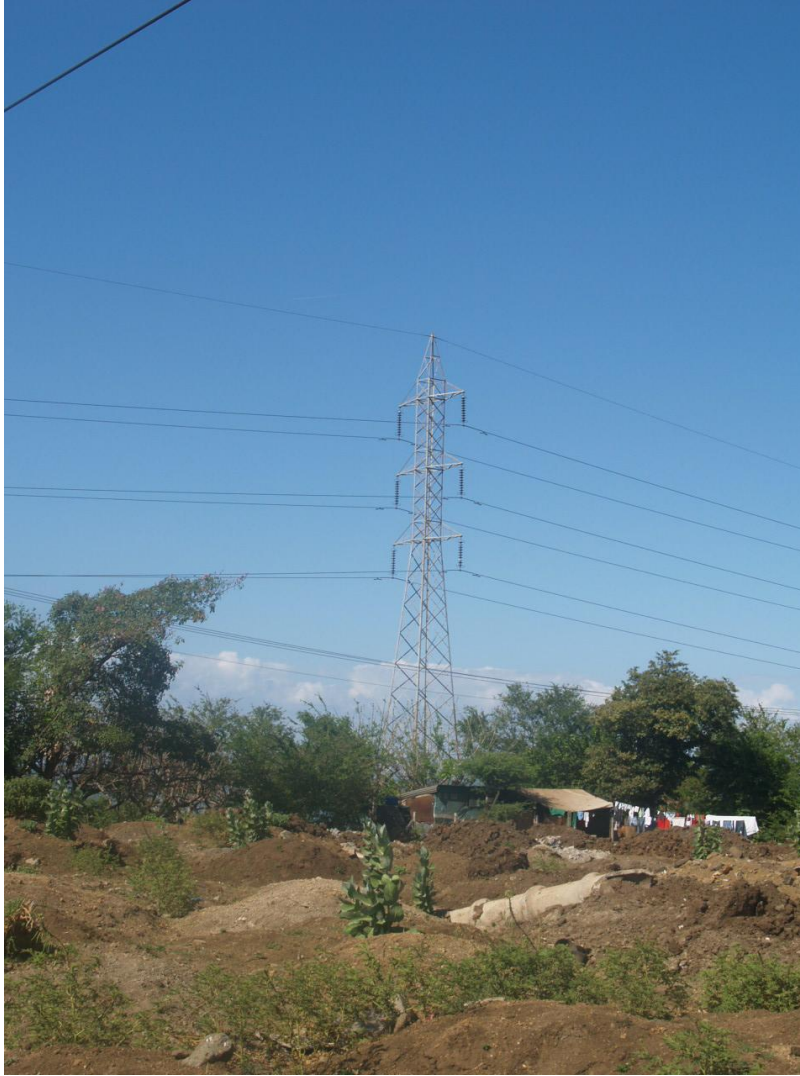
Foto 7.4.2.1: Población invade las áreas restringidas de Torres y Líneas de Trasmisión de alta tensión.
