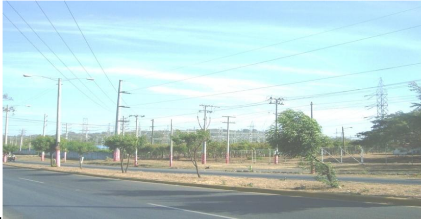
Foto No. 7.1.2.1 Acceso a la Subestación Masaya II
