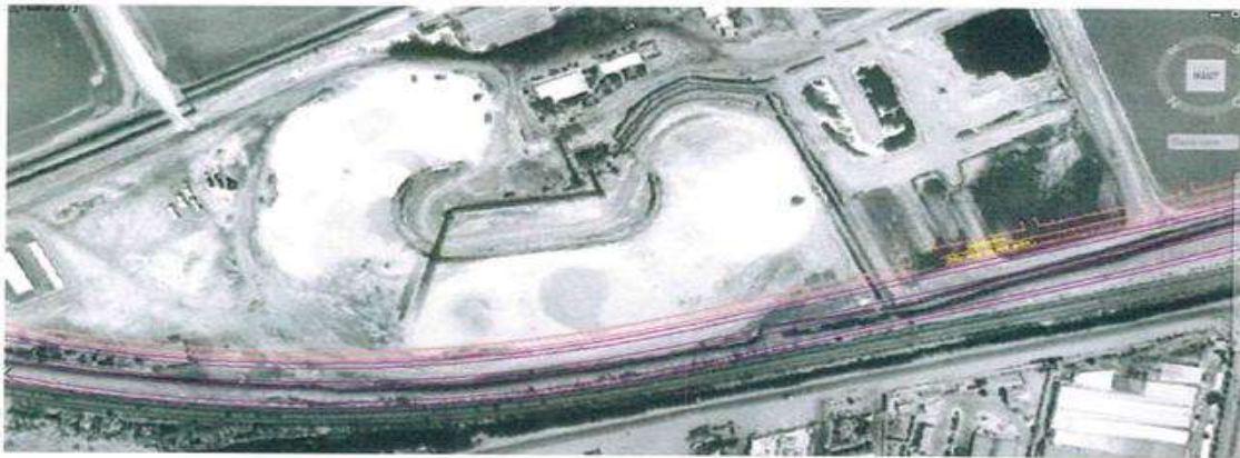
FIGURE 6 : TRACE AERIEN SUR AIRE DE STOCKAGE SALINES
