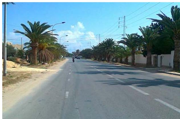
A partir du Pk 1+850 l'emprise se réduit et l'aménagement consiste à réaménager la route en 2x2 voies de largeur 14m sans séparateur et avec deux trottoirs de part et d'autre.
