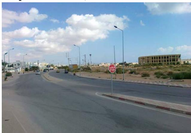
Ensuite le tracé traverse l'oued Ezzit où un ouvrage d'art de type pont dalle existant qui est récemment doublé, la route est aménagée en 2x2 voies avec un TPC et deux trottoirs de part et d'autre. Ce tronçon sera conservé y compris l'ouvrage :
