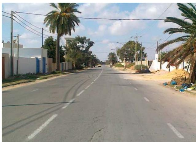
L'emprise de la route RL924 disponible au niveau de la traversée de Sidi Mansour présente une chaussée en 2x2voies non séparées de largeur totale 14m avec deux trottoirs de part et d'autres, cette emprise est généralement suffisante pour l'aménagement d'une chaussée en 2x2 voies avec TPC et deux trottoirs de part et d'autre :
