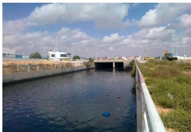
Ensuite l'axe est confondu avec l'axe du boulevard principal du PAD de Taparura où un canal trapézoïdal est aménagé au TPC du boulevard prévu :
