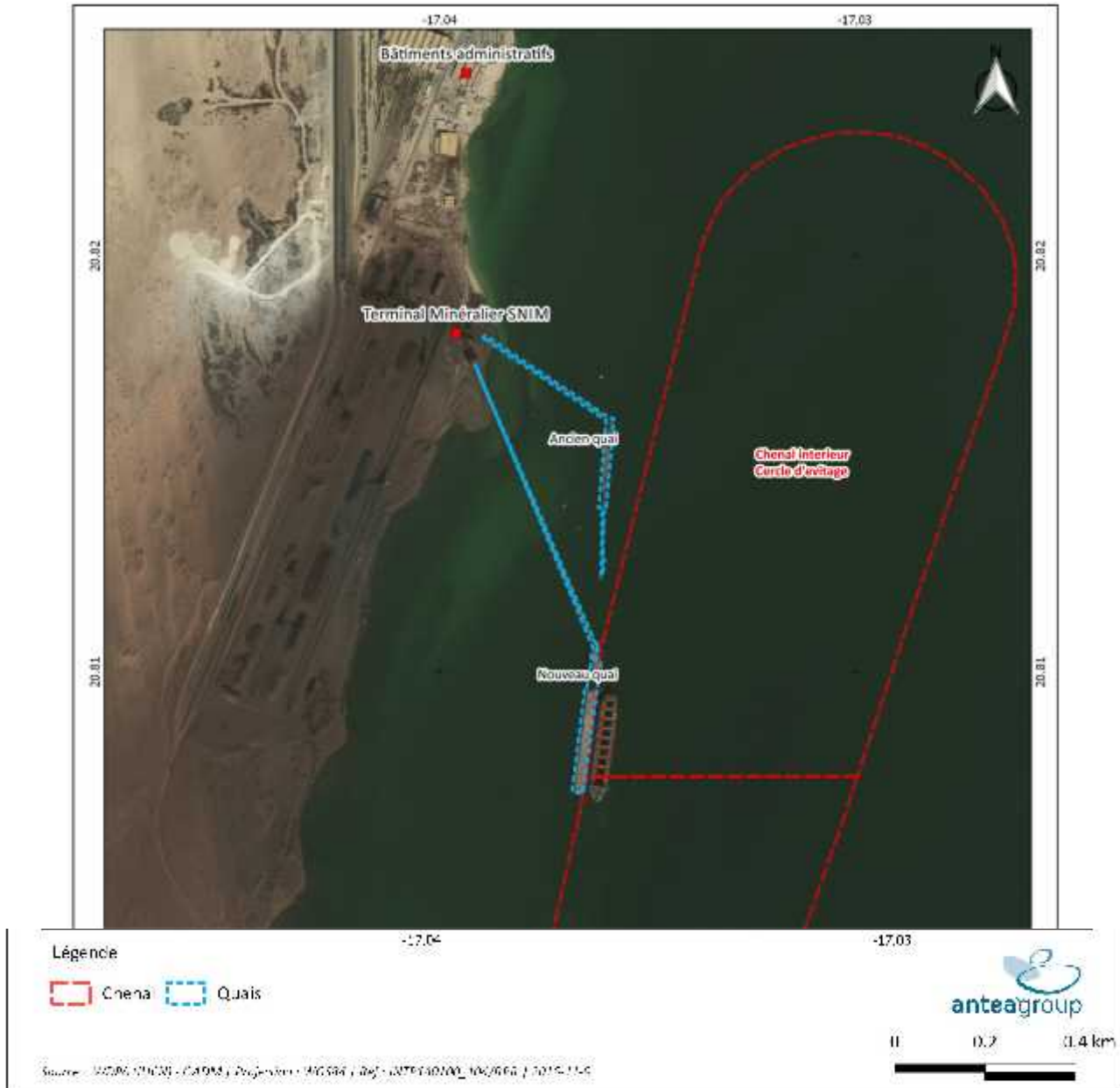
Figure II - 11 : Accès actuel au terminal minéralier de la SNIM
