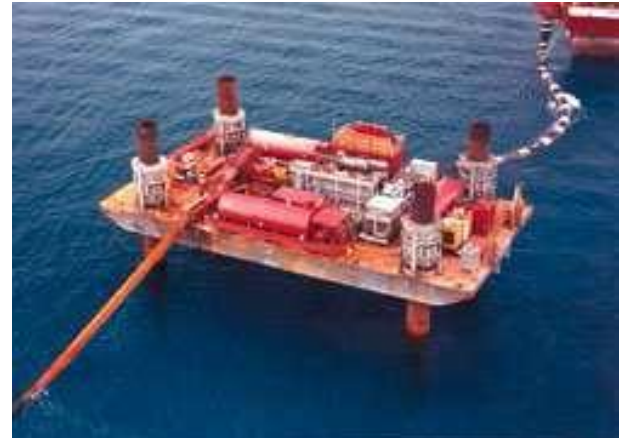
Figure III - 67 : Plateforme en mer sur pieux permettant l'utilisation d'une pompe relais (source ISL, Ingérop)
