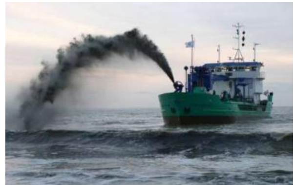
Figure III - 73 : Exemple de rejet des matériaux dragués en direct à faible profondeur
