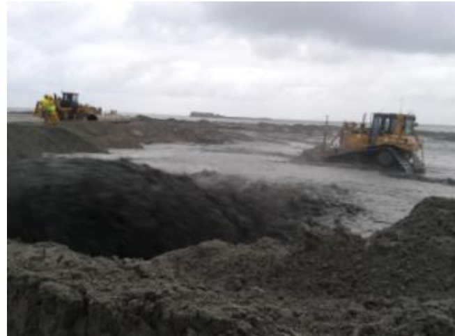
Figure III - 76: Création d'un terre-plein portuaire par refoulement des matériaux dragués hydrauliquement via une conduite de refoulement (Source Antea Group)
