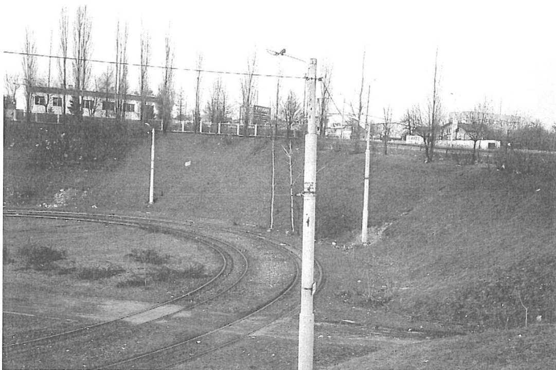
Fot. 2 Pętla tramwajowa przy ul. Braci Mieroszewskich – wlot do tunelu.
