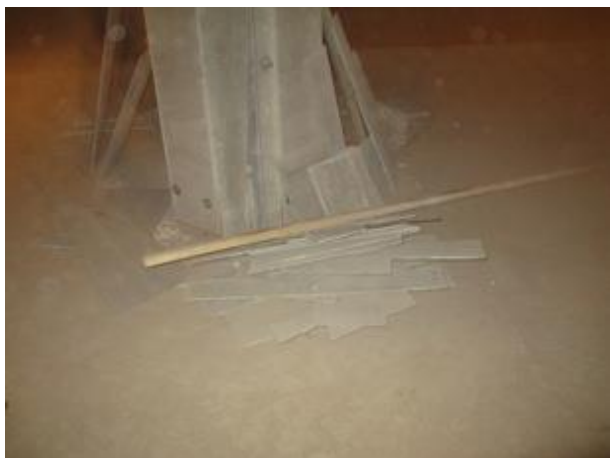
Рисунок 15. Використання азбестовмісних матеріалів на станції «Перемога»
