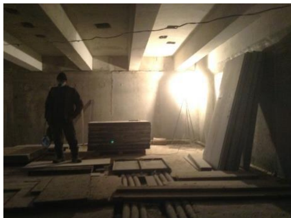
Рисунок 16. Використання азбестовмісних матеріалів та відсутність належних засобів індивідуального захисту у працівників підрядника на станції «Перемога»
