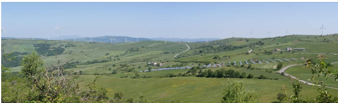
Foto 1 – Vista complessiva dell'area del parco eolico esistente da dismettere
